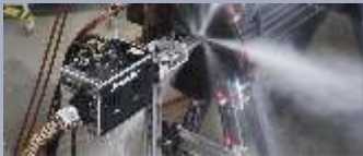
Remoción de fajas o pintura de señalización en asfaltos
