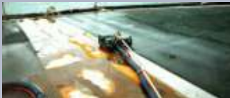
Remoción de fajas o pintura de señalización en asfaltos
