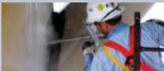
Restauración de Estructuras
