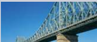
Manutención de Puentes
