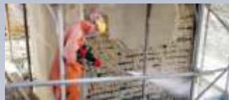
Escarificación de Concreto
