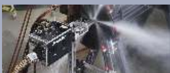
Limpeza de Tubos
