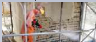
Escarificação de Concreto
