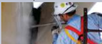
Restauração de Estrutura
