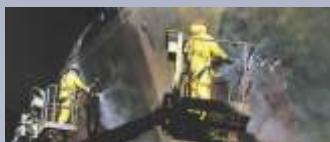
Estaleiros e Plataformas
